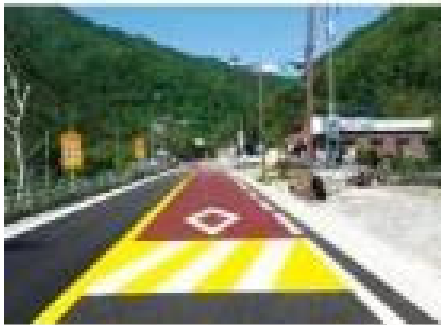
응착식 플로스틱 도로 시공 사례
